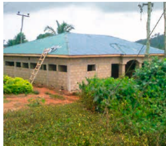
Et nytt sanitærbygg ved Assin Kyinaso i sørlige Ghana takket være Soroptimistklubbene Accra og Kumasi. (Foto: www.soroptimisteurope.org )
